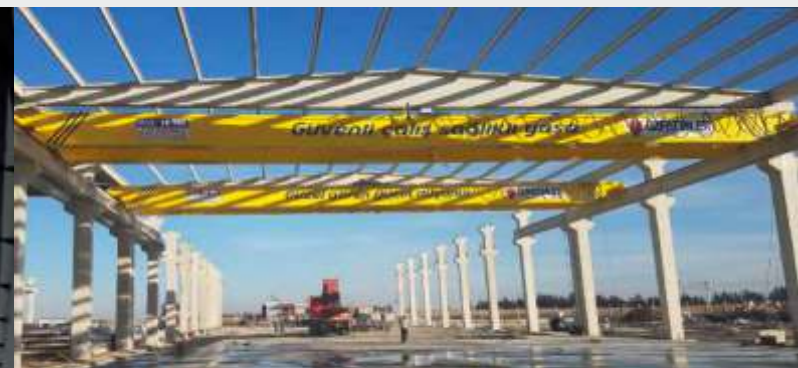
СТРОИТЕЛЬНАЯ КОМПАНИЯ AYDOĞANLAR, ТУРЦИЯ
