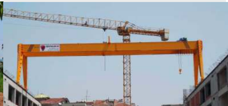
КОЗЛОВОЙ КРАН, СТРОИТЕЛЬНАЯ КОМПАНИЯ ÖRTAŞ, ТУРЦИЯ
